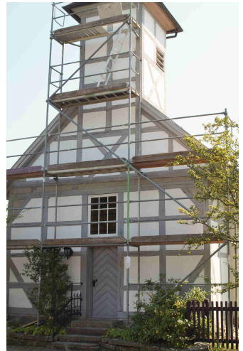
Unsere Alte Kapelle ist „eingerrüstet“
