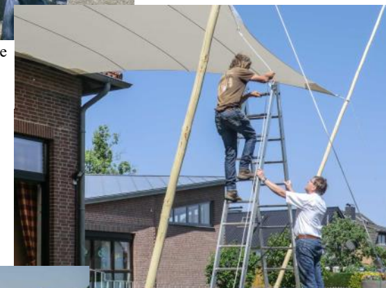
Letzte Arbeiten am Terrassen-Segel
