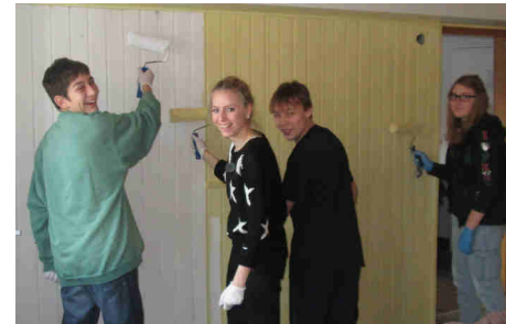
Um die Kellerräume neu zu gestalten, waren meh-
