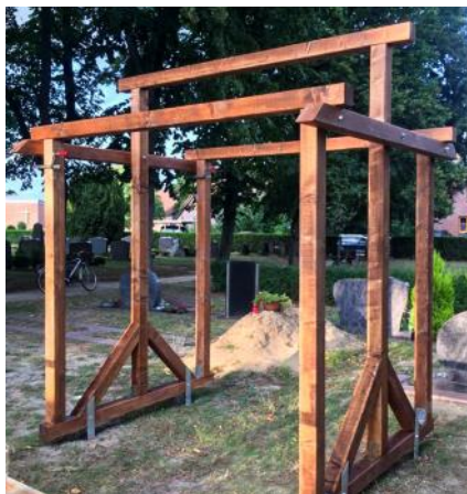
Das Grundgerüst ist fertig gestellt
